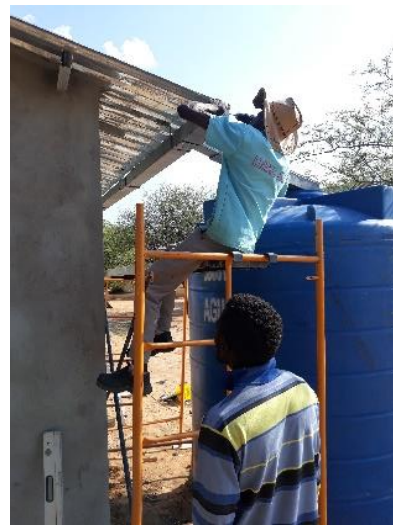
Sadevesikourun asennus sadeveden keräämiseksi vesisäiliöön
