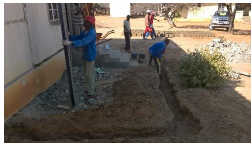
Sementtiharkkojen valmistusta ja vesiputkilinjan kaivuutyö.
